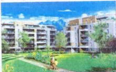
Une partie de programme social de base hébergé, qui se voit le jour sur la grande Saennette, vient d'être livrée aux constructeurs à l'initiative de la ville Jean-Benoît et de l'Agence communale d'habitat, sous la propriété de Val Savoie habitat. 38 logements seront proposés en location sociale.
