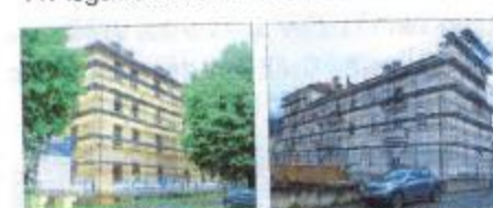
Les opérations de réhabilitation, réalisées en plusieurs étapes, concernent trois résidences : le Champ de Mars, les Tilleuls et le Lysier (à droite).
